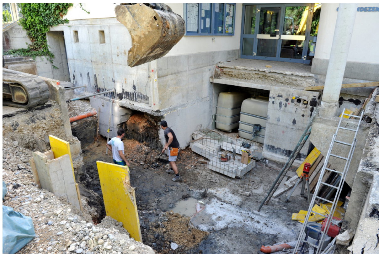
Bauarbeiten Ersatz Holzsnitzelheizung
